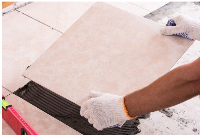
Gambar 9 Pemasangan granit
