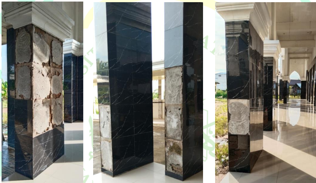
Gambar 16 Sisi tiang besar yang granitnya terlepas.
