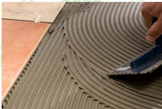
Gambar 8 Meratakan pasta perekat pada dinding
