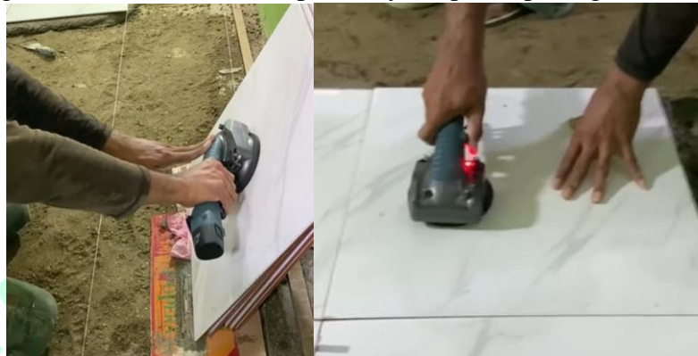
Gambar 12 Penggunaan vakum dan getar alat vibrator
