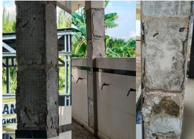
Gambar 20. Bidang rekatan yang tidak penuh dengan pasta perekat
