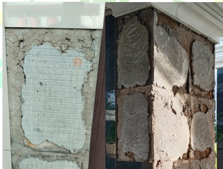
Gambar 19 Bekas pasta perekat dengan warna yang bagus, tetapi tidak penuh
