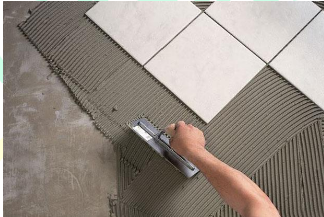
Gambar 7 Pembuatan Dasaran
