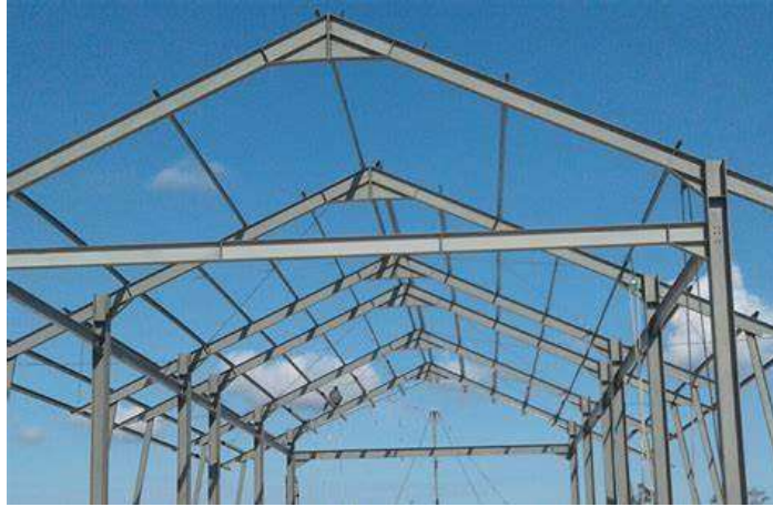
Gambar 5.5 Atap rangka Baja WF
