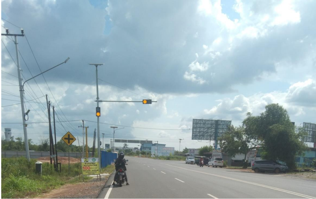
Gambar 4.7. Rambu kecepatan lalu lintas diproyek jalan bandara pesawat samsudin noor.
