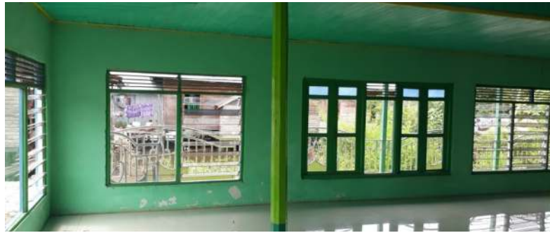
Gambar 7. Dinding pasangan bata
