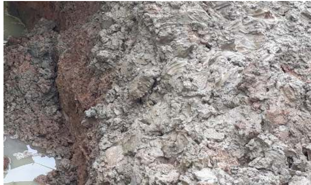
Gambar 10. Kondisi riil tanah pada elevasi pondasi
