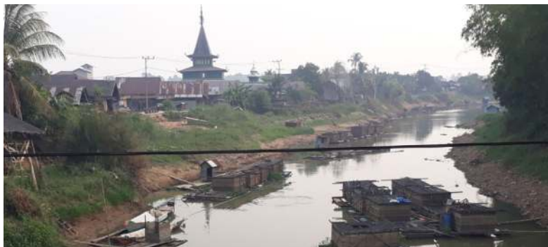
Gambar 11. Kondisi lingkungan masjid dekat dengan Sungai Tabalong
