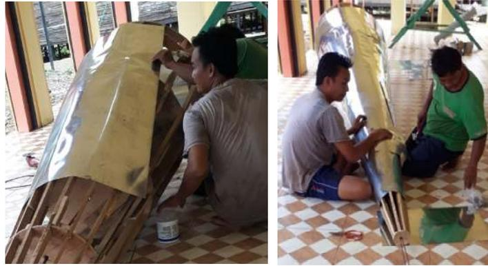
Gambar 11. Pemasangan dinding bekisting berbahan seng.
