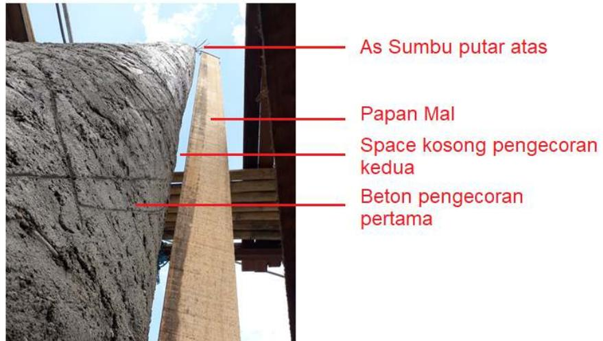
Gambar 21. Pengecoran atap kerucut
